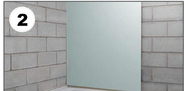
Kleben Sie im nächsten Schritt das erste Paneel auf die Wand und zwar zuerst mit seiner Nutseite. Bedenken Sie, dass Sie unebene Wände ausgleichen (z. Bsp.: Spachteln, Wedi- oder OSB-platte) um eine Verformung der Hydrolock®-Verbindung zu vermeiden und um sicherzustellen, dass die Verbindung gerade und lotrecht ist, was eine sichere und geschlossene Fuge gewährleistet.
