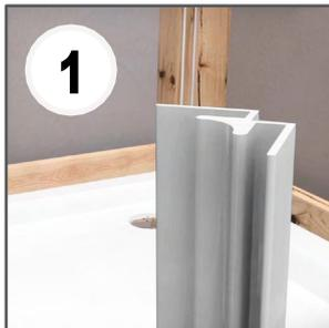
Das erste Profil – in der Regel ein Inneneck- oder Abschlussprofil – wird mittels Klebstoff direkt auf der Wand befestigt. Dabei wird zwischen Profil und Wandpaneel durchgehend silikoniert.
