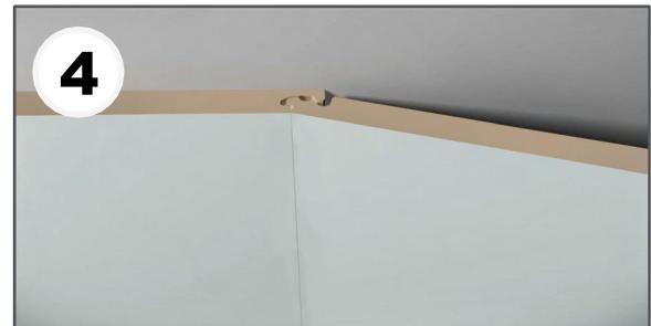
Setzen Sie das nächste Paneel in einem Winkel von zunächst 45° an der Nut des bereits montierten Paneeles an. Stellen Sie dabei sicher, dass die Feder auf ganzer Paneellänge in der Nut des ersten Paneeles setzt, bevor Sie das zweite Paneel an die Wand drücken, um eine Beschädigung der Nut- und Feder-Verbindung zu vermeiden.
