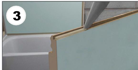
Kleben Sie die beiden später aufeinander stoßenden Dekorlaminat-Paneelkanten (= die Vorderseiten) mit Kreppband ab, um so das Laminat vor überschüssigen Silikon zu schützen. Tragen Sie nun eine 2 bis 3 mm dünne, durchgehende Silikonschicht auf der Vorderseite der Feder (schmale Kante) auf.
