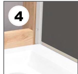
Tragen Sie auf die Rückseite des Naturepanel® unseren Klebstoff auf, schieben Sie das Paneel in die Innenecke und drücken Sie das Paneel dann fest an die Wand.
